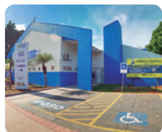
Unidade de saúde com acessibilidade em Campo Grande, Mato Grosso do Sul, 2023.
