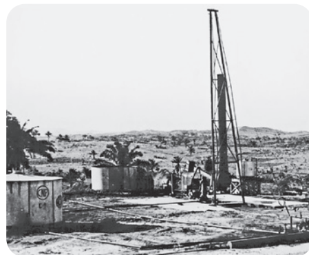
Imagem de poço de petróleo em Candeias, no Recôncavo Baiano, Bahia, 1941.
