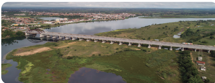
Ponte sobre o Rio São Francisco, na divisa dos estados de Alagoas e Sergipe, entre os municípios de Piranhas e Canindé de São Francisco, 2009.
