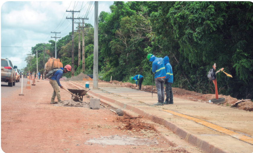
Trabalhadores construindo calçada com piso tátil às margens da Avenida Cuiabá, em Santarém, Pará, 2024.
