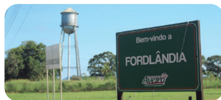
Caixa-d'água da fábrica em Fordlândia. Aveiro, Pará, 2021.
