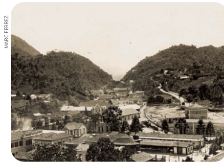
Parte de área urbana da cidade de Petrópolis, no estado do Rio de Janeiro, 1889. Detalhe para as casas e as ruas em construção.
