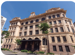
Palácio dos Correios, sede da Agência Central, na cidade de São Paulo, 2024.
