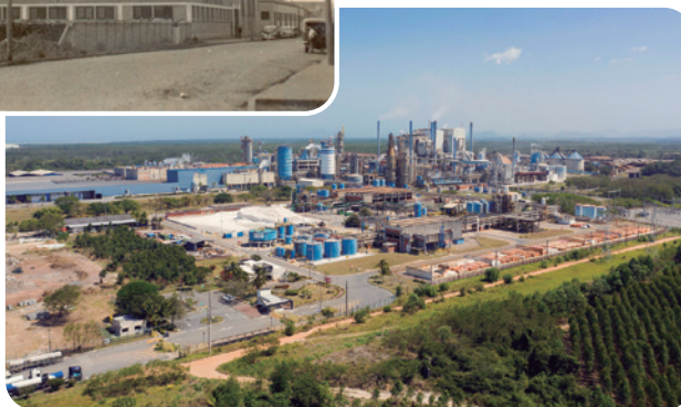
Instalações atuais dessa indústria em Barra do Riacho, distrito de Aracruz, Espírito Santo, 2019.
