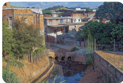
Esgoto sendo lançado no Córrego do Roma, Rio Casca, Minas Gerais, 2024.
