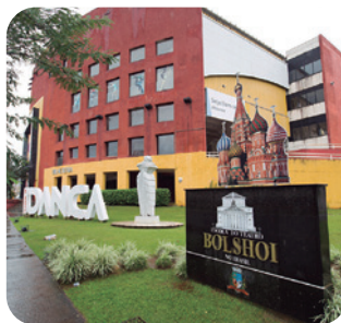
Fachada da Escola do Teatro Bolshoi no Brasil, Joinville, Santa Catarina, 2017.
