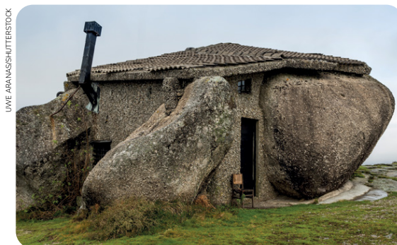
CASA DO PENEDO, 1972, PORTUGAL. TEM ESSE NOME PORQUE FOI CONSTRUÍDA COM QUATRO GRANDES PEDRAS QUE SERVEM DE PAREDES DA CASA. FOTO DE 2021.
